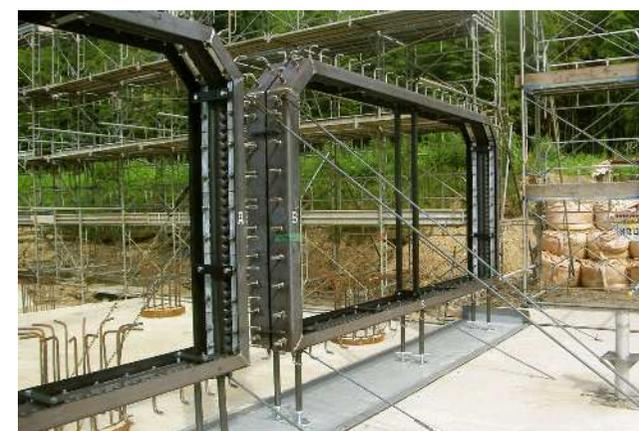
ジョイントが変形する事で、構造物の不等沈下や伸縮を吸収します。またジョイント締着部凸条を圧縮する事により構造物との間の浸水を完全防止します。
