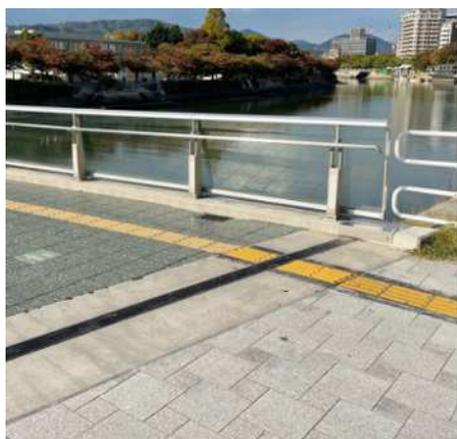
橋梁用の伸縮装置であるブロッジョイント。車走行時に伸縮継目部に掛かる圧力の強度を向上し、雨や寒さにも強い装置を製造しています。
