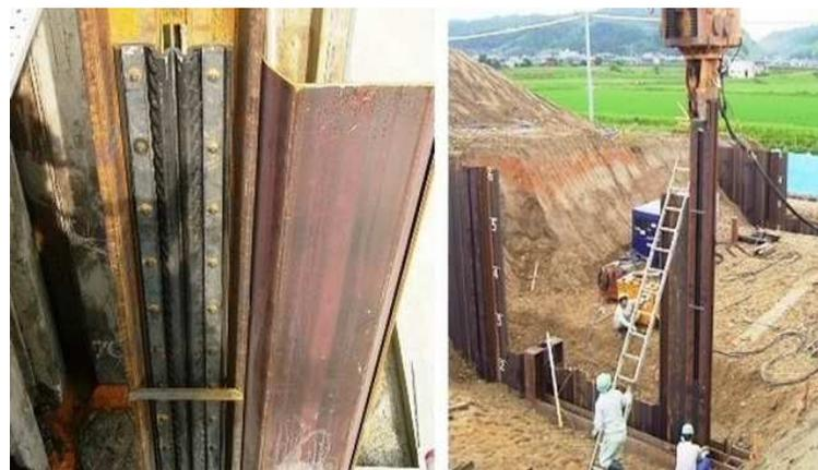
堤防の沈下などの変位、負の周面摩擦力の影響を遮断するため鋼矢板用可撓継手を設けるよう構造基準が定められており、その基準に基づいた製品となります。
